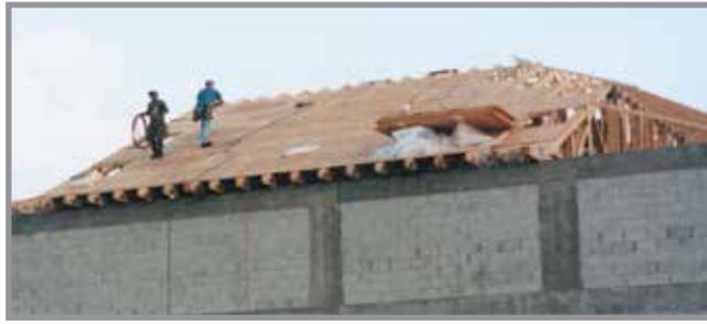
Cargas de construcción son las cargas que están impuestas a los edificios incompletos como resultado del proceso de construcción. Cargas de construcción típicas incluyen el peso de los trabajadores, el equipo y los materiales de construcción, etcétera. Por ejemplo, un paquete de entablado contrachapado o tabla de yeso apilados temporalmente sobre los trusses crean cargas de construcción.
